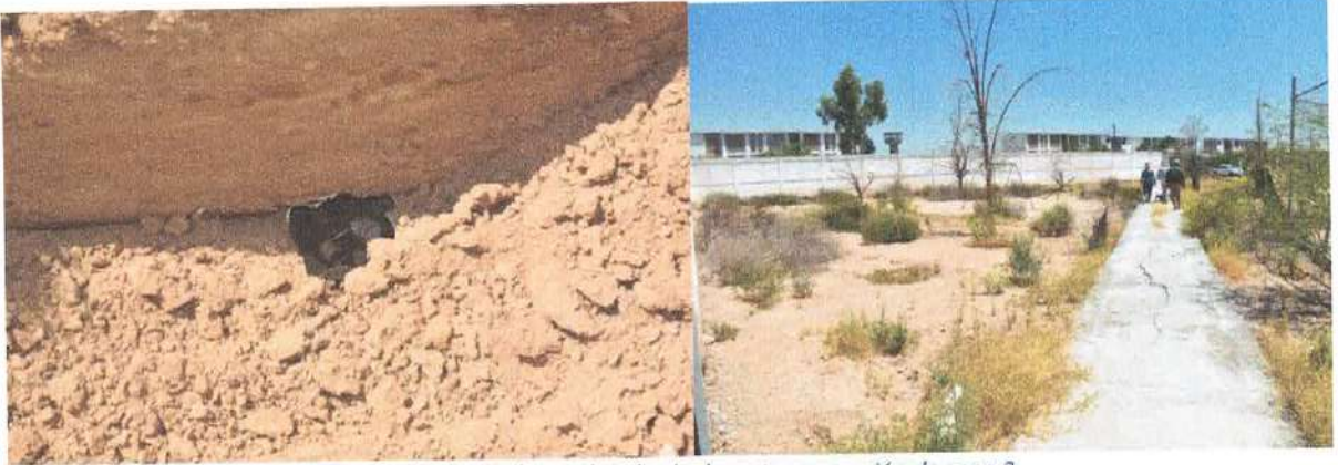
Fotografía 5.- Hallazgo de tubería durante excavación de zona 2
