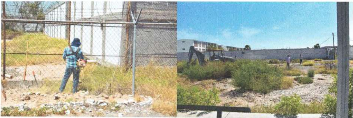
Fotografía 1.- Limpieza manual y con maquinaria
