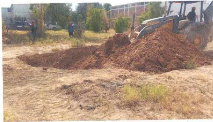
Fotografía 14.-Excavación controlada con maquinaria en zona 5, marcada como zona critica
