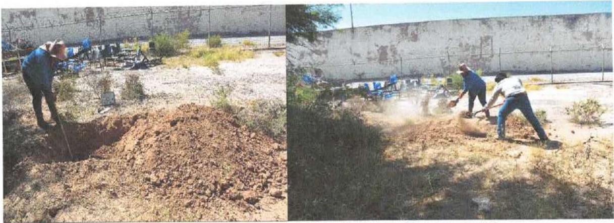
Fotografía 15.- Excavación manual en zona 5 área conocida como comedor
