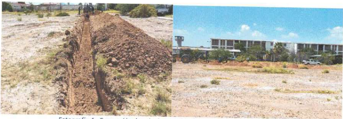
Fotografía 4.- Excavación de cala de aproximadamente 30 metros de longitud.
