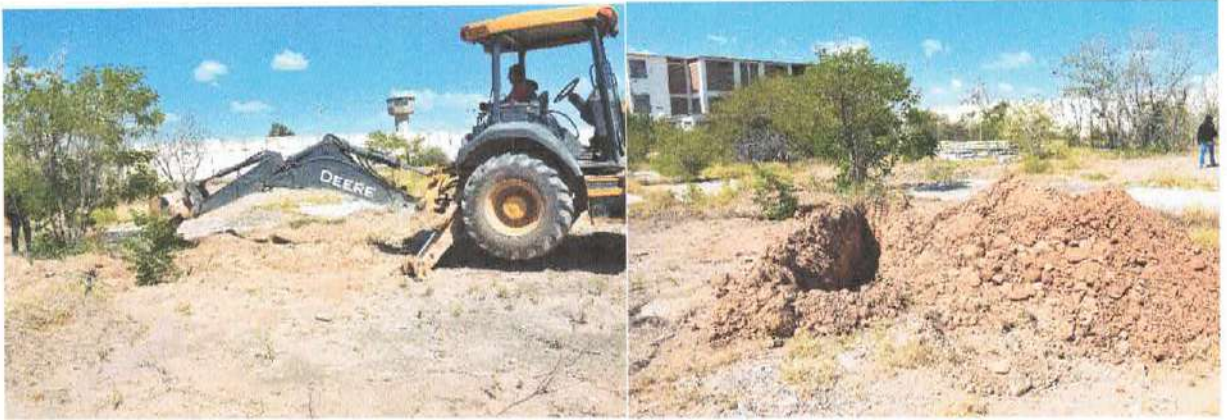
Fotografía 8.-Excavación con supervisión donde se encontró tubería, zona 2
