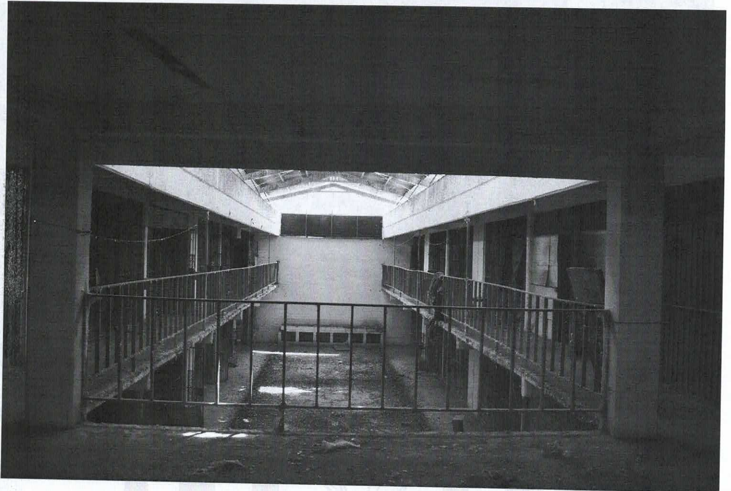
Plano medio donde se observa el segundo piso de las celdas antiguas instalaciones del centro de readaptación social de Gómez palacio dgo.
