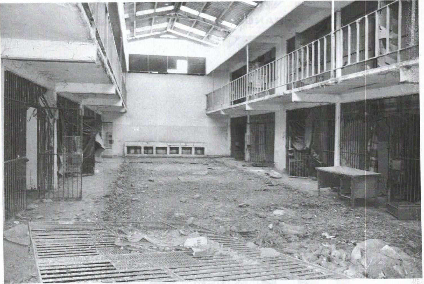
Plano medio donde se observa el interior del edificio de las celdas de las antiguas instalaciones del centro de readaptación social de Gómez palacio dgo.
