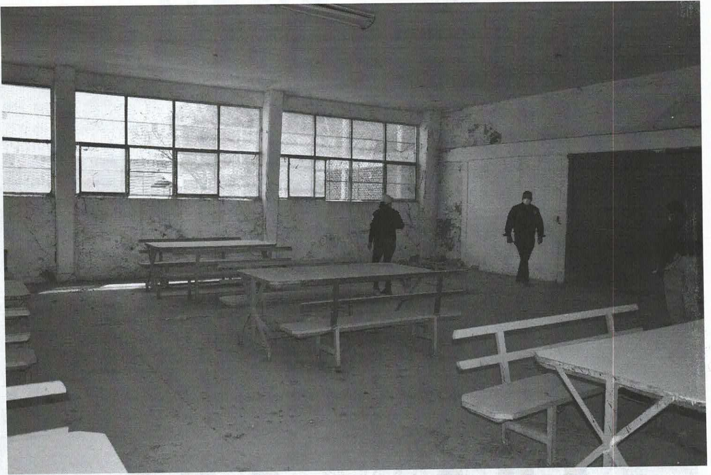
Plano medio donde se observa el interior del comedor de las antiguas instalaciones del centro de readaptación social de Gómez palacio dgo.
