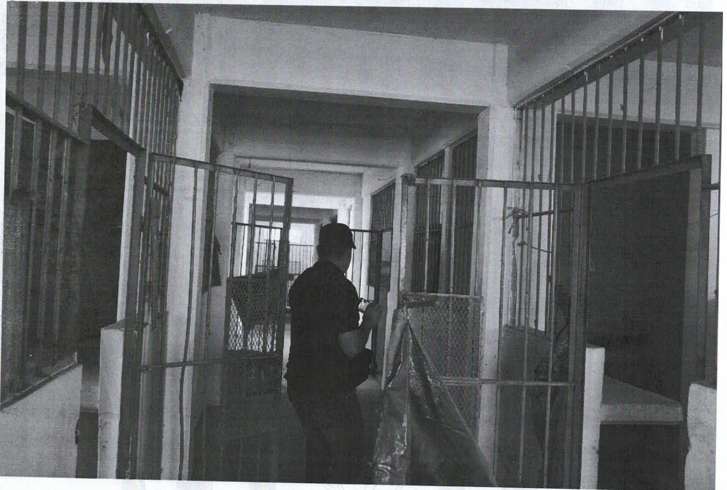
Plano medio donde se observa el interior del segundo piso del edificio "C" de las antiguas instalaciones del centro de readaptación social de Gómez palacio dgo.
