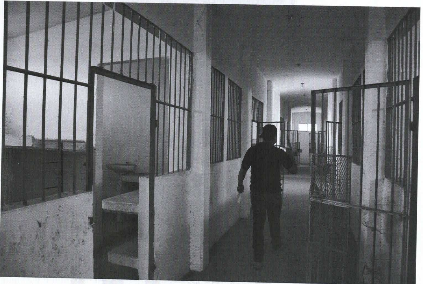
Plano medio donde se observa el interior del tercer piso del edificio "A" de las antiguas instalaciones del centro de readaptación social de Gómez palacio dgo.
