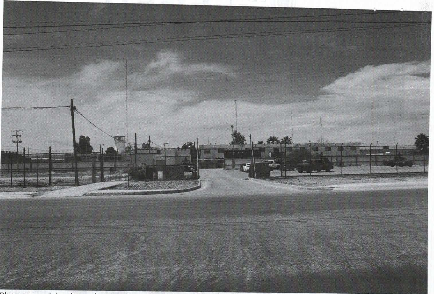
Plano general donde se observa el exterior de las antiguas instalaciones del centro de readaptación social ubicado en CALZADA NIÑOS HÉROES S/N DE LA CIUDAD DE GÓMEZ PALACIO, DURANGO.
