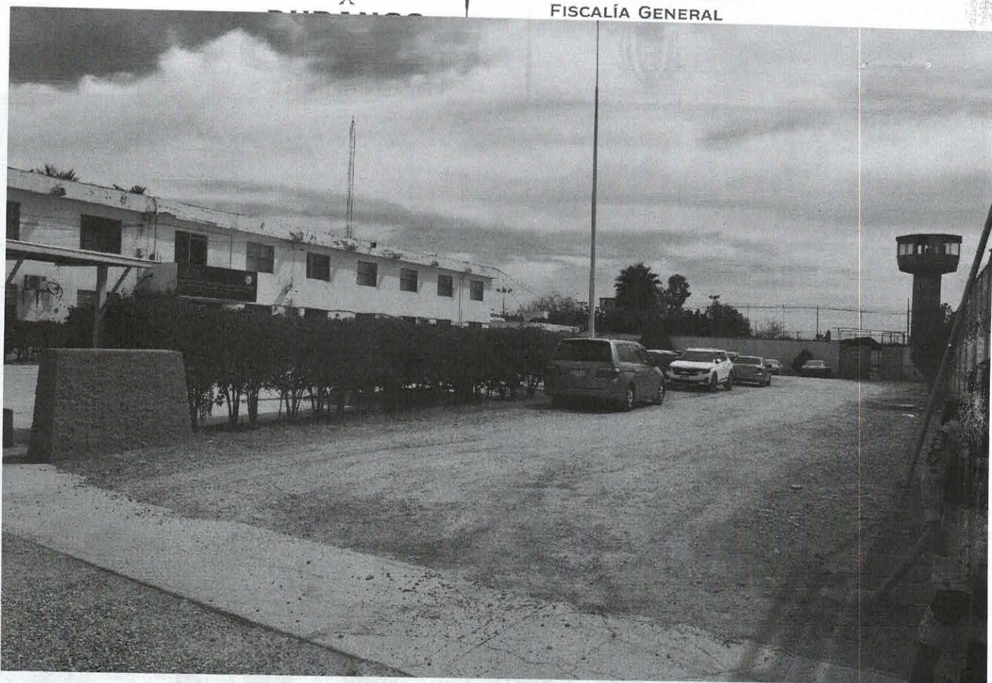
Plano medio donde se observa el área del estacionamiento de las antiguas instalaciones del centro de readaptación social.
