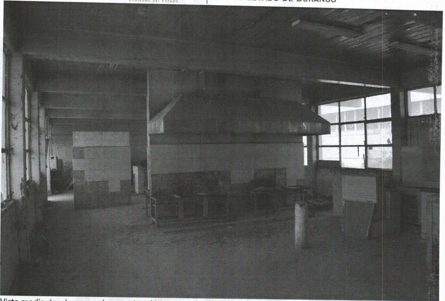
Vista media donde se puede apreciar el interior del edificio correspondiente al área de talleres, observándose los diversos objetos que se localizaron en el interior.
