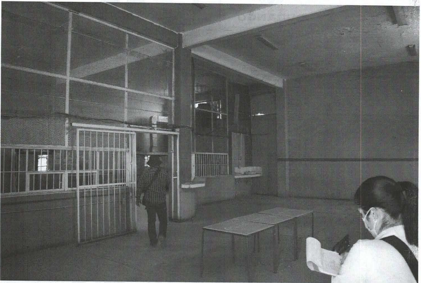
Vista media donde se puede apreciar el interior del edificio utilizado como comedor, observándose el mobiliario encontrado en dicha área.
