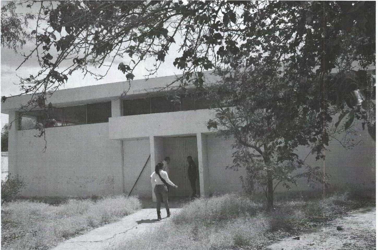
Vista general donde se puede apreciar otro de los edificios que conforman el inmueble sujeto a estudio, mismo que según personal de la policía estatal de Durango, corresponde al área del gimnasio.
