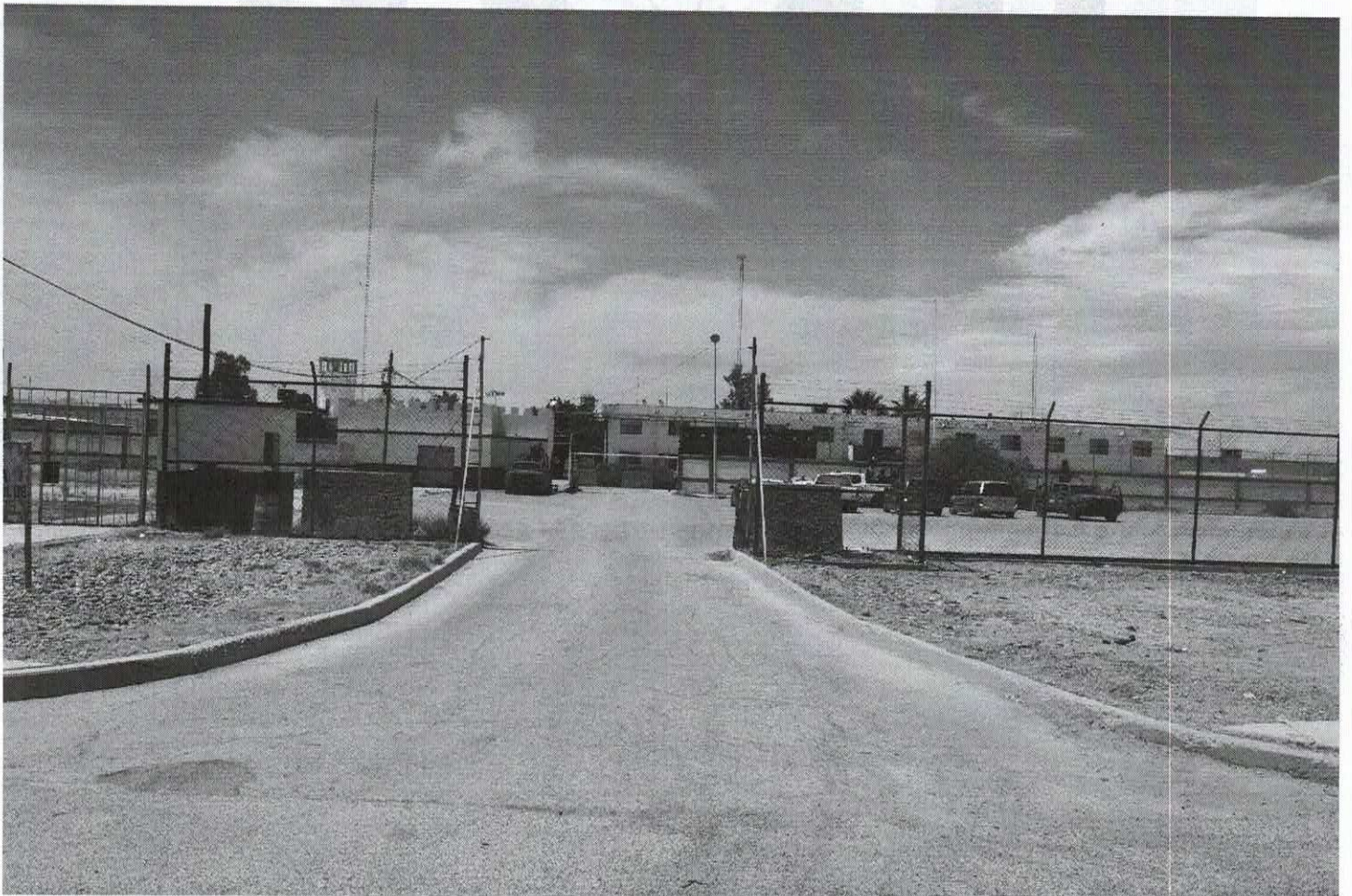
Plano medio donde se observa el exterior de las antiguas instalaciones del centro de readaptación social ubicado en CALZADA NIÑOS HÉROES S/N DE LA CIUDAD DE GÓMEZ PALACIO, DURANGO.
