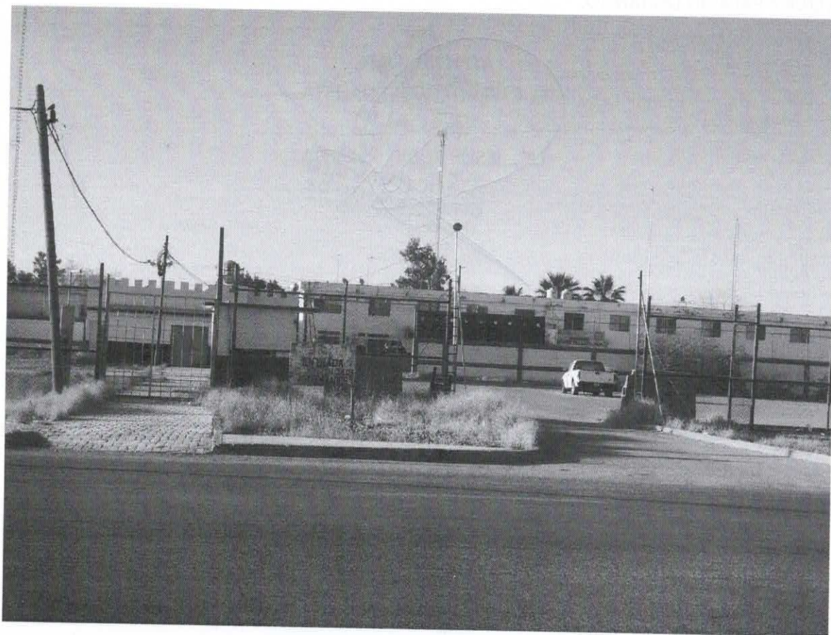
VISTA GENERAL DONDE SE APRECIA LA PUERTA DE ACCESO AL ESTACIONAMIENTO GENERAL DE ESTE LUGAR.
